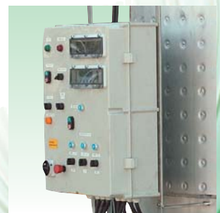
PLC-styring styrer, regulerer, overvåger og registrerer
